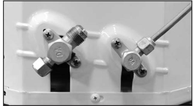
FIG. 38 - CONEXÃO DA LINHA DE EXPANSÃO DA UNIDADE CONDENSADORA
